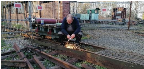
Autogenes Trennen im Gleisbau (hier Wch 17)
