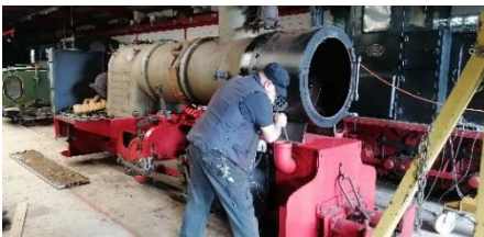
Restaurierungsarbeiten an unserer Dampflok. Der Kessel wird nach dem Tausch aller Rauchrohre wieder montiert.
