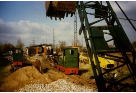
Bau des Gleisvorfeldes in Oekoven 1980
