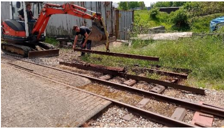
Gleisbauarbeiten (Wch. 17; noch nicht fertig)
